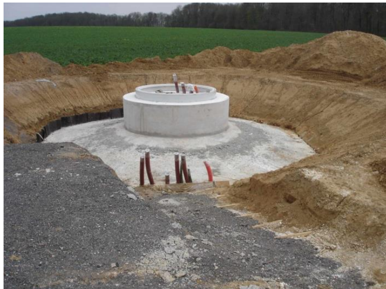
Fondation d'une éolienne
