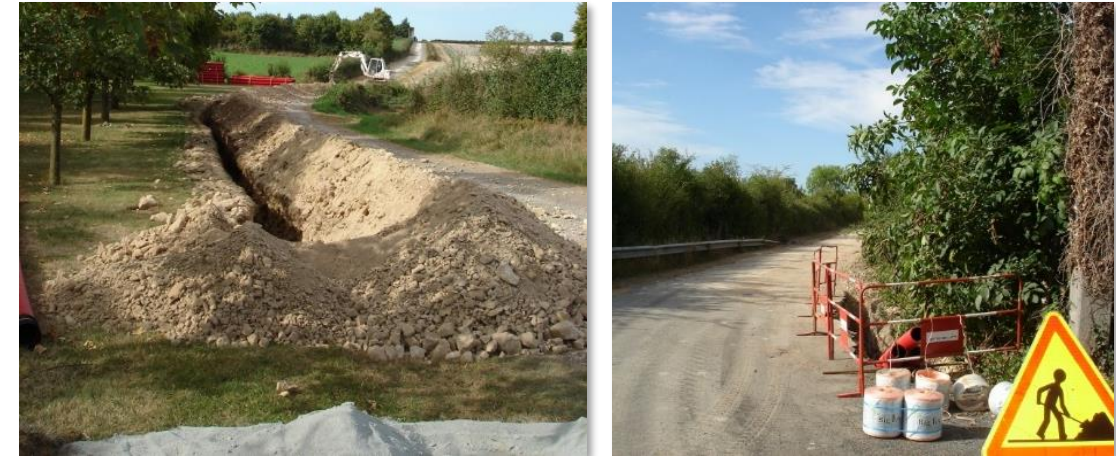
Tranchée pour le raccordement au réseau local (Source : VALOREM)
