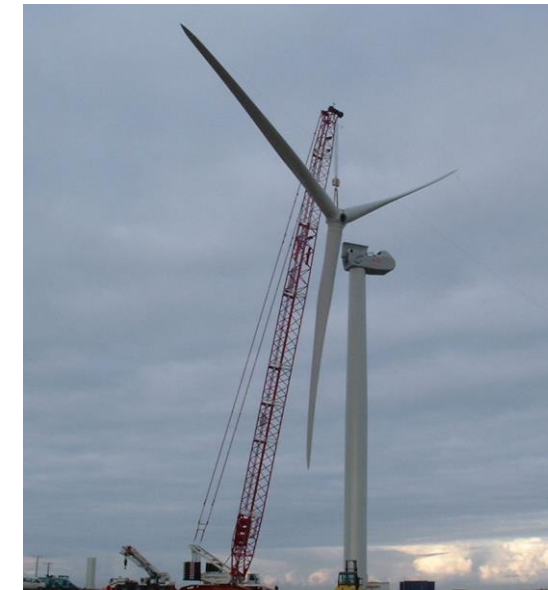
Montage du rotor
