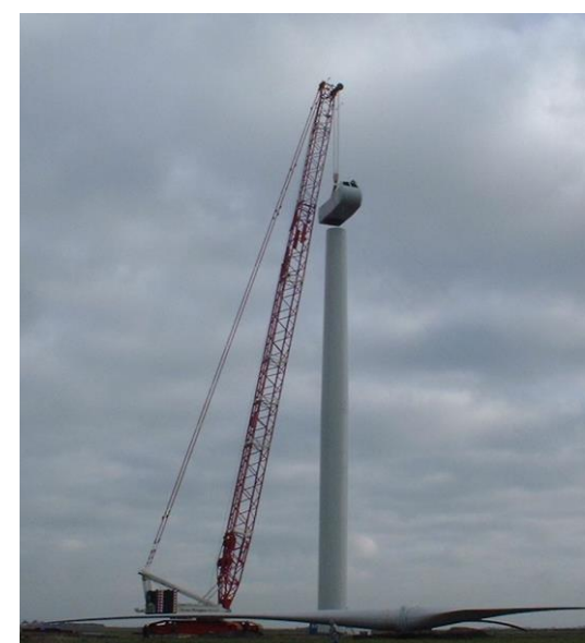
Montage de la nacelle
