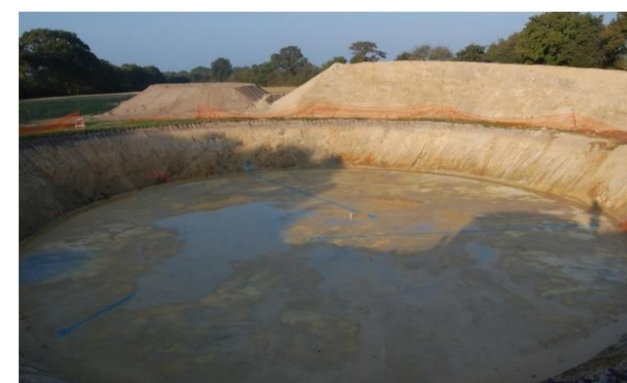
Excavation pour la fondation
