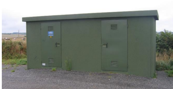
Simulation visuelle du poste de livraison n°1
